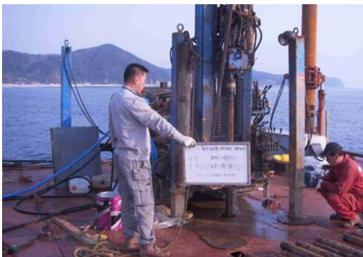
(a) 시추조사 전경
