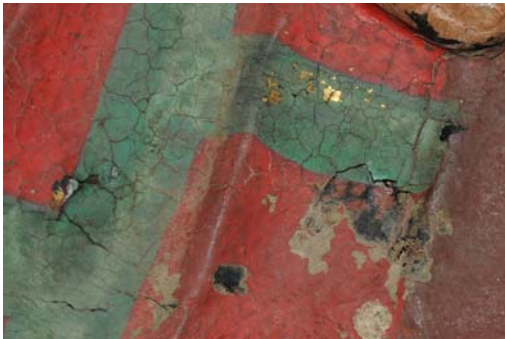
i. 표면층 균열
