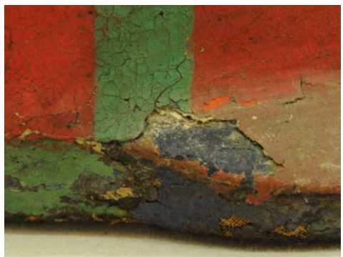
f. 채색층 균열로 인한 탈락
