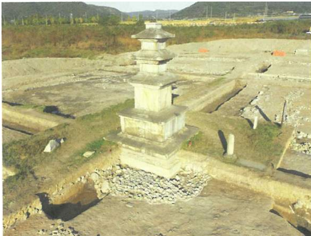
<그림 88> 미탄사지 석탑 하부 지정층 및 서편 트렌치 위치도 (박찬문 2022:224 <사진 34> 전재)
